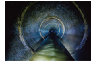
市政管道检测
